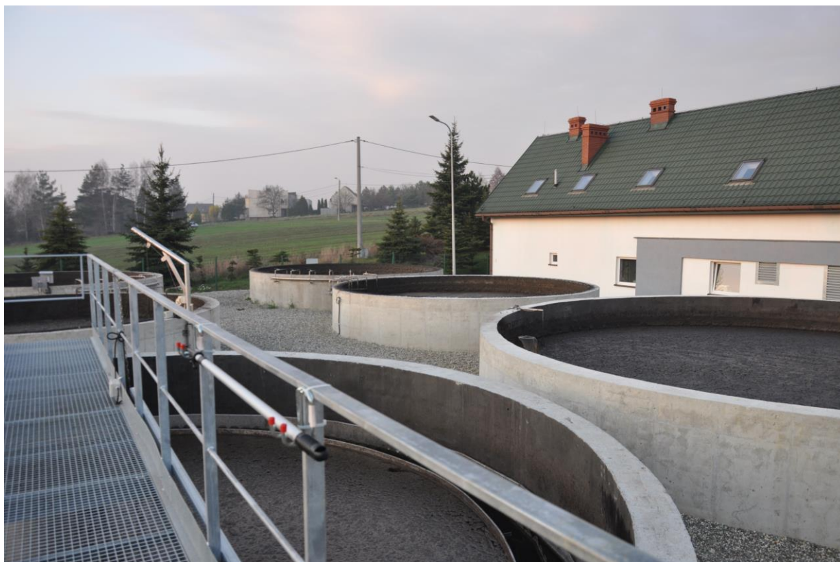
Oczyszczalnia - efekt finalny inwestycji
