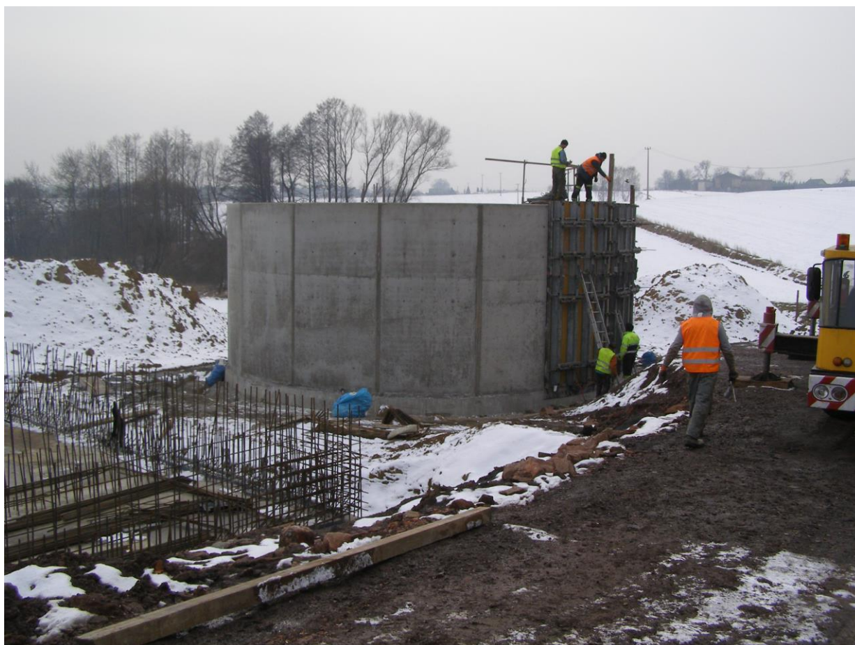
Modernizacja oczyszczalni, ul. Śląska
