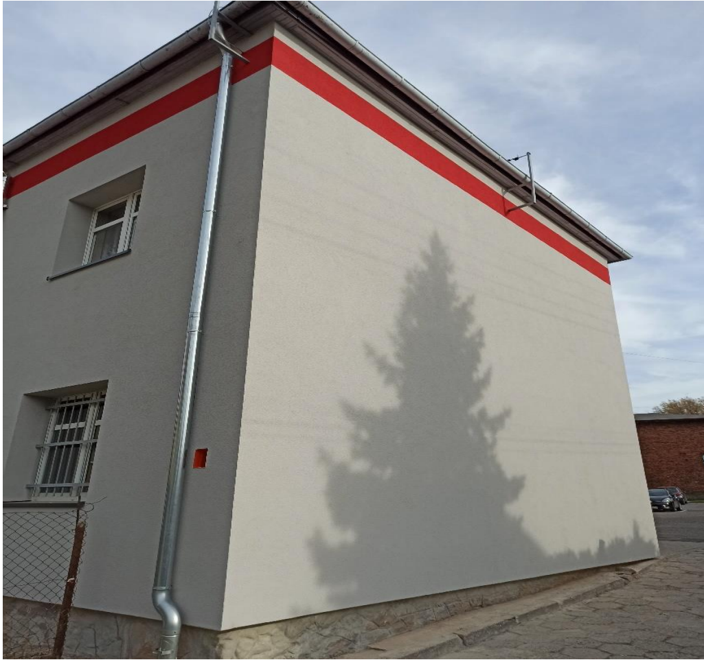
Fotografia 1. Budynek OSP - Poprawa efektywności energetycznej budynku
